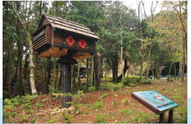
架設在雪見遊憩區的全國首座大型蝙蝠屋
